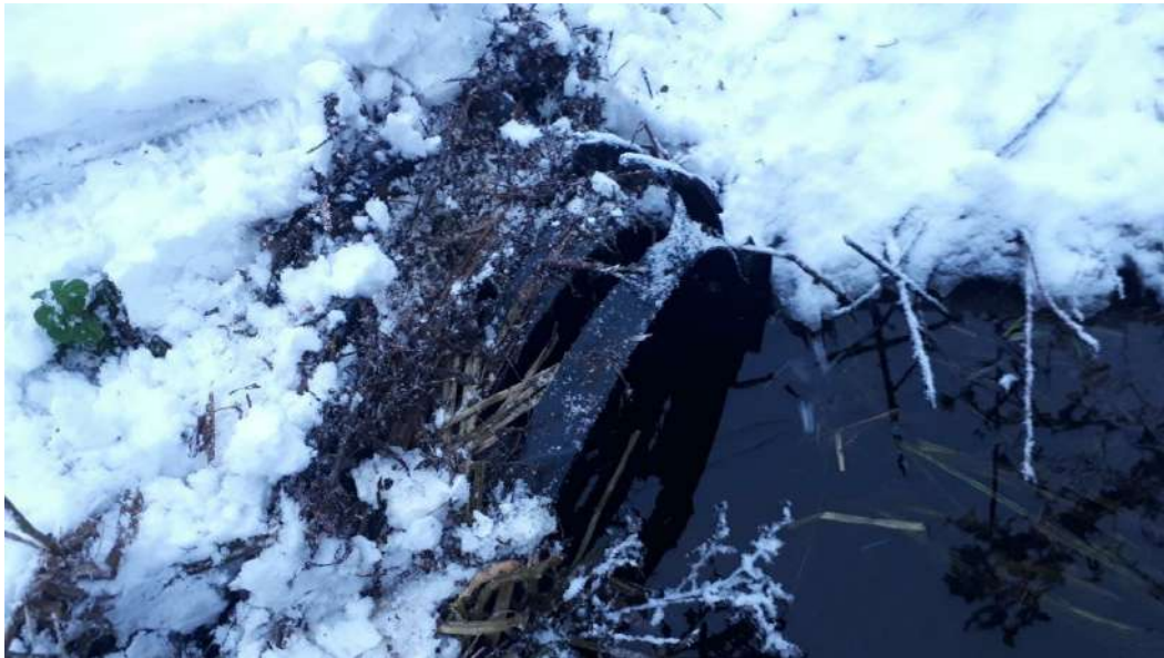
Foto 6. Vaade truubi T4 sissevoolule (24.11.2023). Truup heas seisundis. Sisse- ja väljavoolul kividest otsakud. Plastoru otsad on (tõenäoliselt) niitmise käigus saanud kahjustada.
